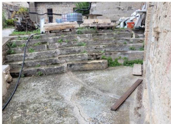
Fig. 7 - La documentazione fotografica mette in evidenza dello stato fessurativo che dallo spigolo del monastero si estende verso le scale che risultano ruotate verso il fiume.
